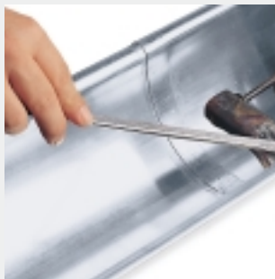
Topnik nakładany jest za pomocą pędzla na całej powierzchni elementów, które mają być połączone...
